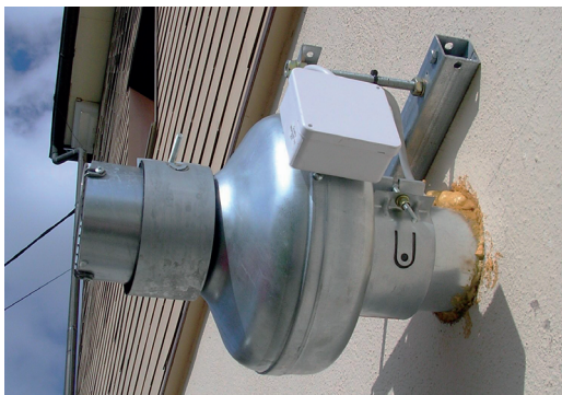
Ein außen liegender Ventilator erzeugt einen leichten Unterdruck unter der Bodenplatte.
