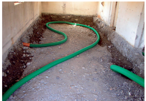
Erneuerung des Fußbodenaufbaues: Einbau einer Radondrainage.
