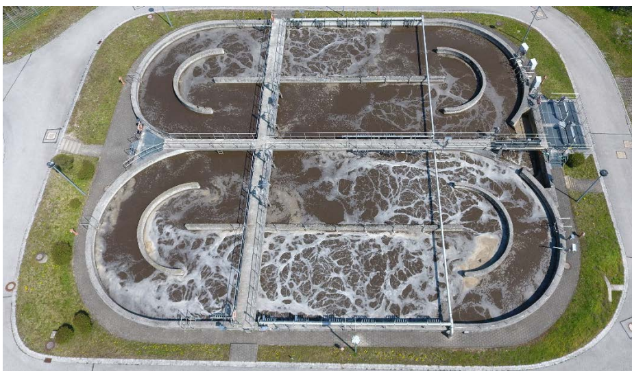
Abb. 15: Belebungsbecken der Kläranlage Weilheim in Oberbayern
