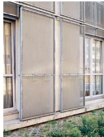
Die verschiebbaren Fassadenelemente sind aus verzinktem Streckmetall gearbeitet oder mit Nylongewebe bespannt. Sie können als Sicht- und Sonnenschutz eingesetzt werden.
