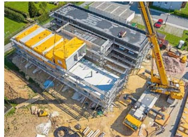
Die vorgefertigten Module wurden auf der Baustelle montiert und bauseits angepasst.
