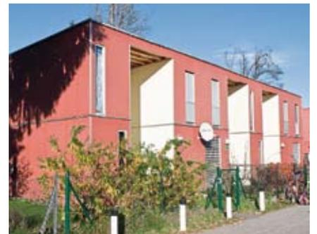
Die Faserzementplatten erhielten nach einigen Jahren eine farbige Gestaltung.
