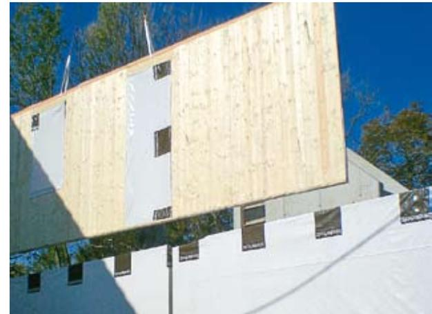
Um die Bauzeit zu verkürzen, wurden vorgefertigte Brettsperrholztafeln verwendet.
