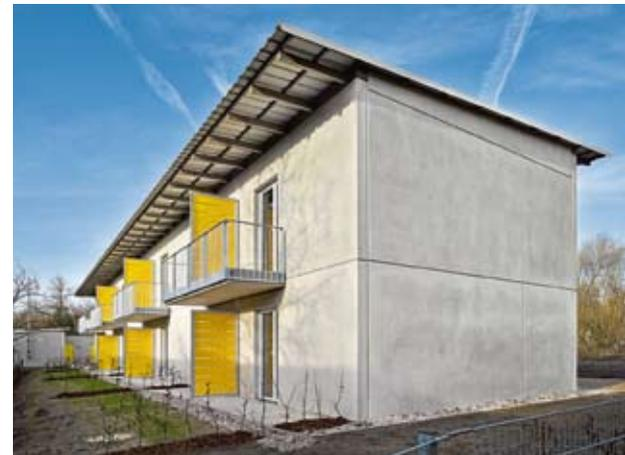
Die Sandwichelemente wurden in Sichtbetonqualität ausgeführt. Die Gestaltung lässt zu, dass die Fertigungsart der Außenwände erkennbar bleibt.
