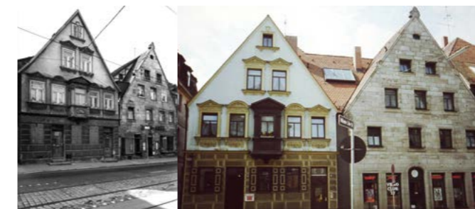
Königstraße 36/38, Fürth, Vorderseite vor und nach der Sanierung, 1975 © Wohnungs- und Siedlungsbau Bayern GmbH & Co. OHG, Foto: Kurt Otto
