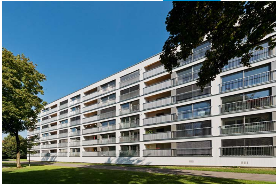
Wohnanlage Grünenstraße Augsburg, lattkearchitekten, 2012 | Nach der Sanierung, Ansichten © lattkearchitekten, Foto: Eckhard Matthäus
