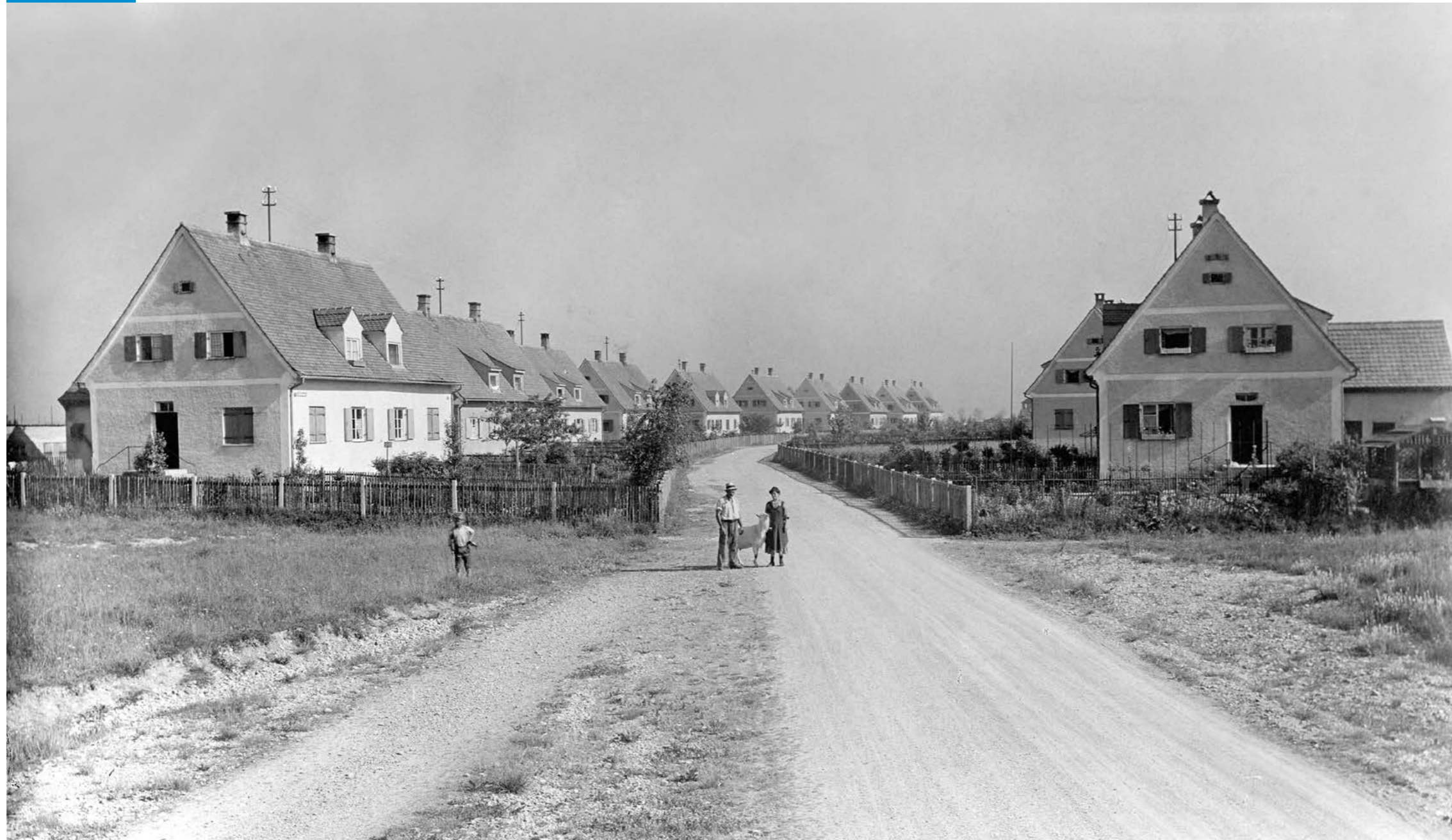
Selbstbausiedlung Firnhaberu, Augsburg, Albert Kirchmayer, 1921–1939 © Siedlungsgenossenschaft Augsburg-Firnhaberu eG
