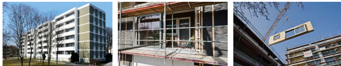
Wohnanlage Grünenstraße Augsburg, lattkearchitekten, 2012 | Bestand vor der Modernisierung, Versetzen und Montage der vorgefertigten Ausbauelemente, Baumaßnahmen in bewohntem Zustand © lattkearchitekten
