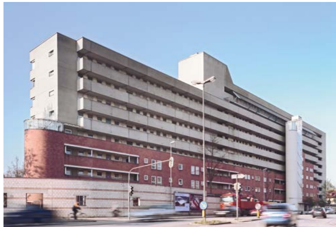
Umbau des Wohnhochhauses in der Hindenburgstraße, Ingolstadt, Thomas Sieverts, 1990 Nach der Modernisierung © Foto: Florian Schreiber
