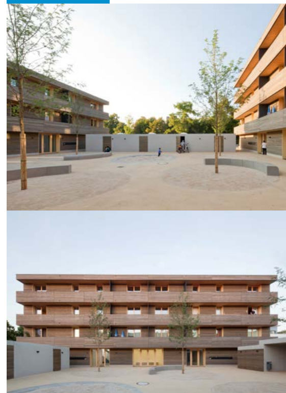
Wohnanlage Herbartstraße Ansbach, Deppisch Architekten, 2012–2013 | Grundriss EG, Blick von Süden in den Hof und auf die westliche Hoffassade © Deppisch Architekten, Foto: Sebastian Schels
