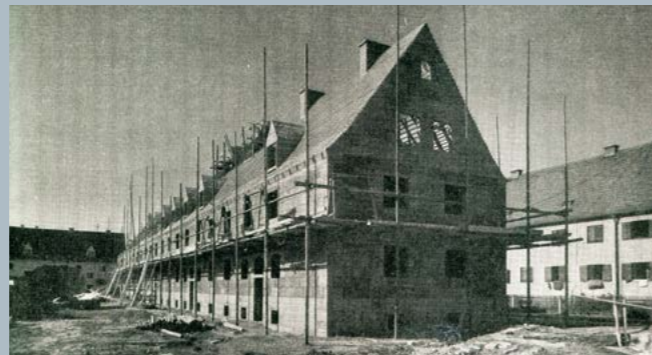
Wohnblock in Ingolstadt, Außenwände aus Ziegelsplittplatten mit Ziegelsplittfüllung, um 1950 in: Baumeister 4/1950, S. 251
