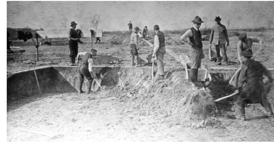
Selbstbausiedlung Firnhaberu, Augsburg, Albert Kirchmayer, 1921–1939 | Ausheben der Baugrube durch die Siedler © Siedlungsgenossenschaft Augsburg-Firnhaberu eG
