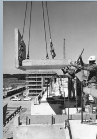
Montage von Balkonen als Stahlbetonfertigteil in der Siedlung München-Lerchenauer See, 1964 © Wohnungs- und Siedlungsbau Bayern GmbH & Co. OHG, Foto: Christian Zocher
