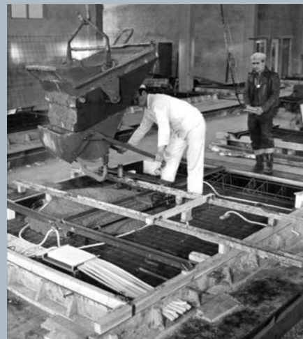
Fertigungshalle der Stahlbetonplatten für Siedlung Nürnberg-Langwasser, 1963 © Wohnungs- und Siedlungsbau Bayern GmbH & Co. OHG, Foto: Hübner
