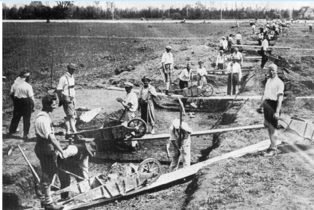
Reichskleinsiedlung Freimann, München, Karl Moschler, 1931 | Grubenaushub © Stadtarchiv München
