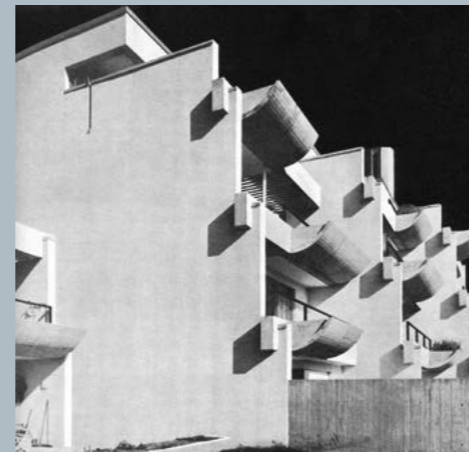
Industrialisierte Bautechniken prägen Fassaden der 1960er- und 1970er-Jahre. Wohnanlage in München von H. Kochta, 1971 | in: Baumeister 2/1971, S. 177
