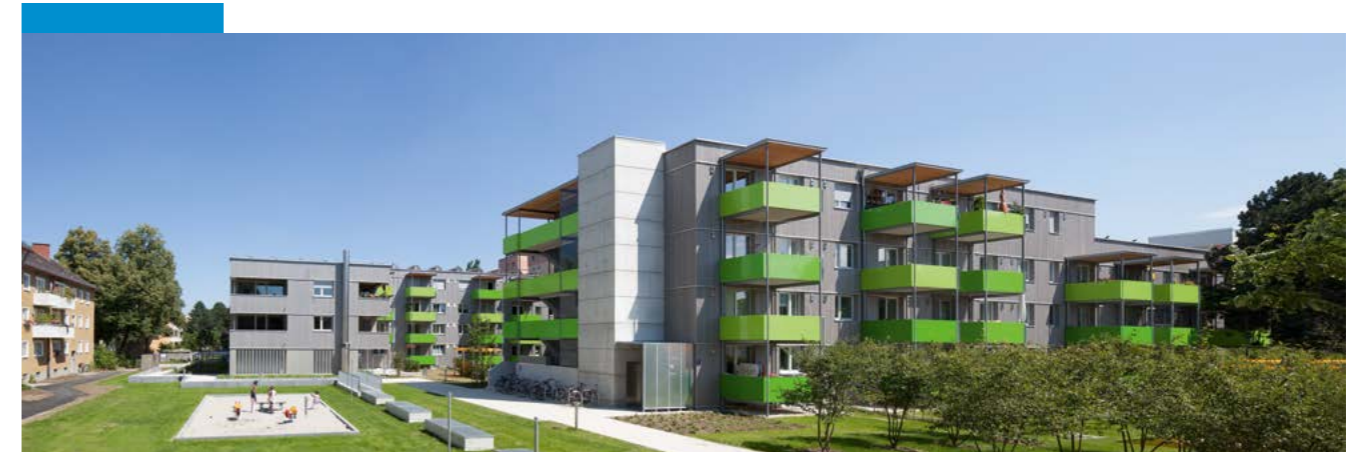
Wohnhausanlage Fernpassstraße, München, Kaufmann, Lichtblau Architekten, 2012–2014 | Nach der Modernisierung © GWG München | Kaufmann, Lichtblau Architekten, Foto: Stefan Müller Naumann
