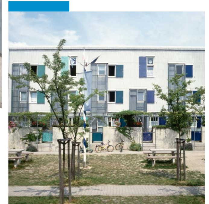
Wohnanlage Passau-Neustift, Hermann Schröder und Sampo Widmann, 1989 | Grundrisse, Ansichten, Schnitt (links unten), Blick in den Hof (links oben und oben) © Hermann Schröder und Sampo Widmann
