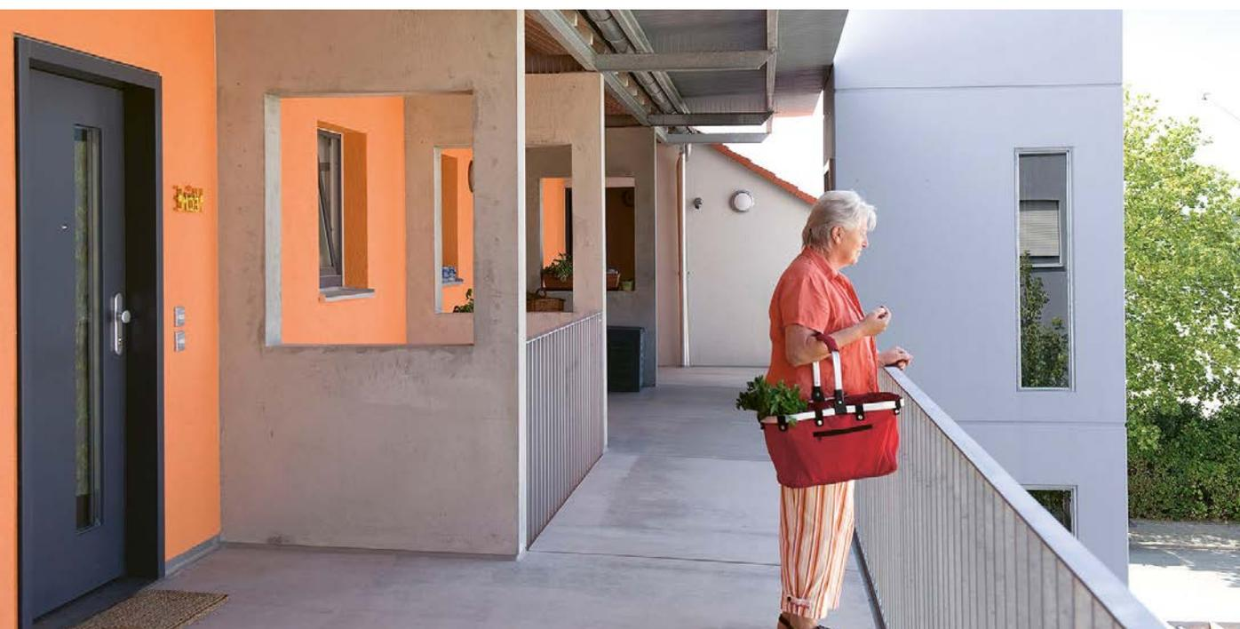
Mit der Aufweitung eines bestehenden Laubengangs wurde die Aufenthaltsqualität erhöht und für die Barrierefreiheit notwendige Bewegungsflächen erweitert. Durch den Anbau eines Aufzugs sind alle Geschossebenen barrierefrei erreichbar.
