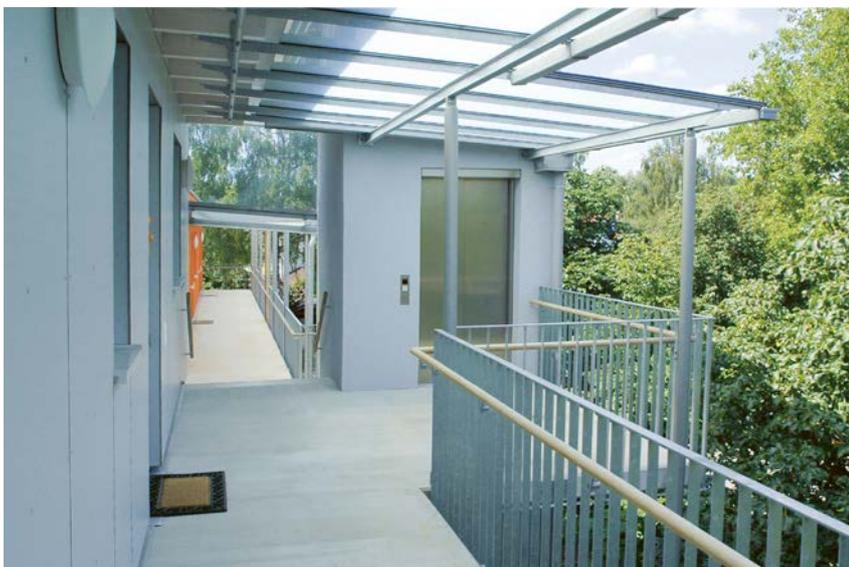
Neue Laubgänge und ein von zwei Seiten benutzbarer Lift ermöglichen die barrierefreie Erschließung des Bestandsgebäudes (grau) und des Ergänzungsbau (orange).
