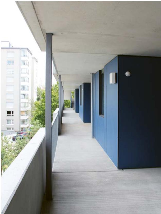
Die angeraute, rutschfeste Betonoberfläche, die durch das Einlegen einer speziellen Matrize in die Schalung erreicht wurde, und die blauen Wände sind stark kontrastierend gestaltet.
