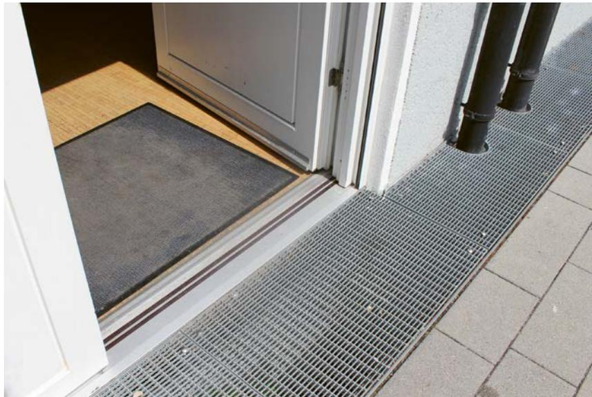
Türen mit Magnetdichtungen ergänzt durch großzügige Rinnen können bei genauer Detaillierung auch im Bestand einen annähernd schwellenlosen Austritt auf die Terrasse ermöglichen.
