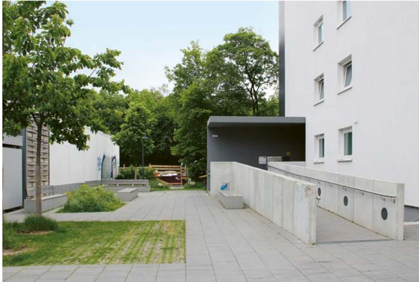
Durch eine Rampe kann das höhergelegene Erdgeschoss des Bestandsgebäudes aus dem Jahr 1963 barrierefrei erreicht werden. Begrenzende Wandscheiben verhindern ein seitliches Überfahren der Rampe. Handläufe zu beiden Seiten ermöglichen die sichere Nutzbarkeit für in der Mobilität eingeschränkte Fußgänger.
