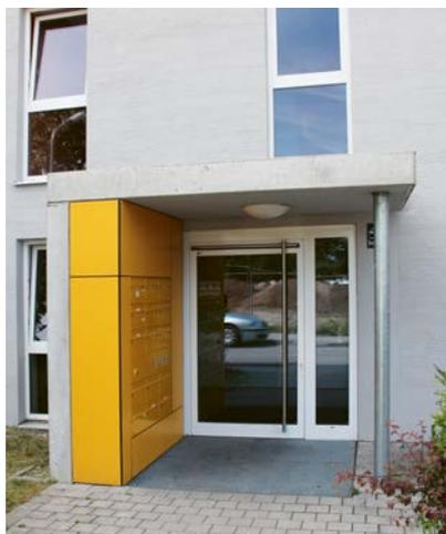
Die farbige Gestaltung der Briefkästen und der Wechsel im Bodenbelag kennzeichnet den Eingangsbereich für sehgeschwache und blinde Menschen. Durch die Deckenleuchte ist eine gute Ausleuchtung gewährleistet. Die vertikal angebrachte Griffstange verhindert eine Verschattung des Türschlosses.
