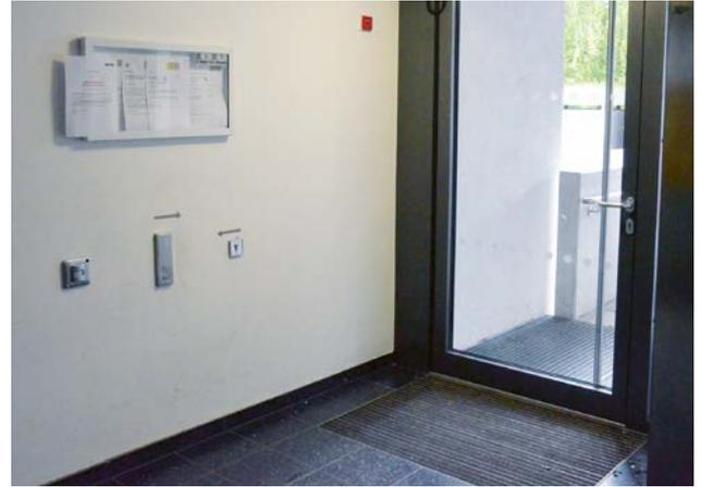
Eine Lichtschranke ermöglicht das automatische Öffnen der Haustüre von innen. Zusätzlich kann die Türe durch einen deutlich gekennzeichneten Schalter in einer für Rollstuhlnutzer geeigneten Höhe betätigt werden.
