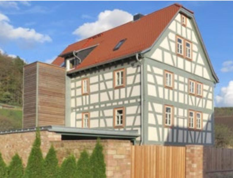
energetische Belange, z. B. bei der Restaurierung der Fachwerkfassaden und Innendämmung mit Leichtlehmsteinen, vorbildhaft miteinander verknüpfen lassen. Der schlichte holzverkleidete Personenaufzug, der ein barrierefreies Wohnen ermöglicht, fügt sich ebenso selbstverständlich an den historischen Baukörper an.
