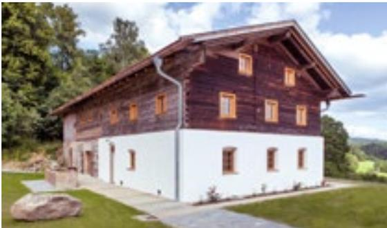
Kappengewölbe an. Obergeschoß und Dachgeschoß wurden in Holzblockbauweise ausgeführt. Das Gewölbe war vor der Sanierung einsturzgefährdet und die Holzbauteile waren durch das jahrelang undichte Dach massiv geschädigt.
