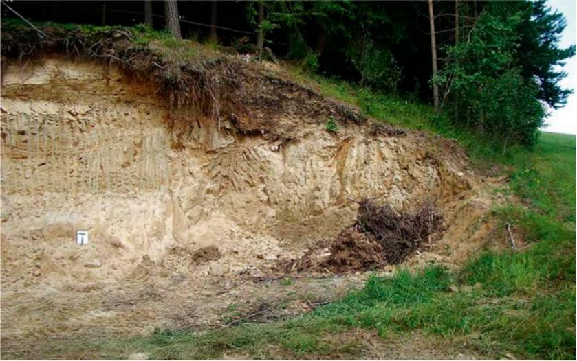
Abb. 24: Intensiv verwitterter und entfestigter Granit in einer Sandgrube E Großarmschlag
