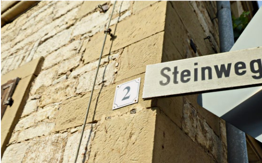
Abb. 28: Bauernhaus in Halsheim, Steinweg 2. Das Mauerwerk besteht aus Bruchsteinen des Oberen Muschelkalks, die Ecken, Simse, Tür- und Fenstergewände sind aus Werksandstein (2020).
