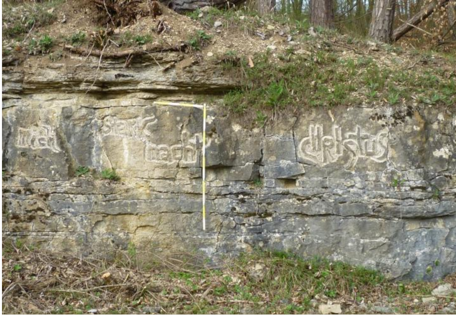
Abb. 25: Die 1. Schaumkalkbank auf der Höhe E Fuchsstadt als Werkstein eines zeitgenössischen Künstlers (vertikaler Maßstab: ein Meter). Die Ortschaften südlich der Saale belegen die Bedeutung dieser Fazies als Baustein.
