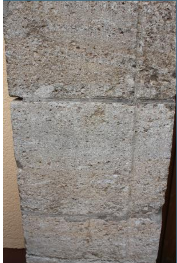
Abb. 5: Exemplarisches Beispiel für die Verwendung des Unteren Muschelkalkes als Naturwerkstein im Stadtgebiet Machtilshausen
