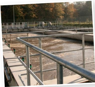
Heute züchtet man diese Bakterien und kleinen Tierchen in Kläranlagen, damit sie für uns das Abwasser reinigen. Damit sie sich besonders wohl fühlen und gut vermehren, wird Luft in das Wasser geblasen. Man nennt diese Becken **Belebungsbecken** (Foto links). In unserem Experiment würde man so den Zucker aus dem Wasser herausbekommen, weil die Bakterien und kleinen Tierchen ihn auffressen würden.
