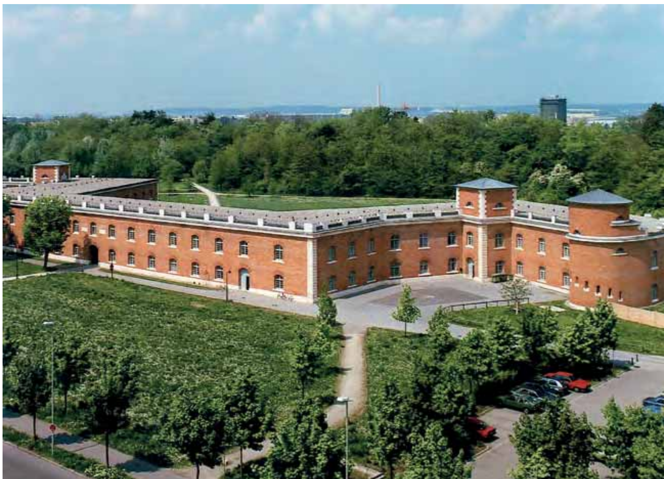
Abbildung 6: Glacis mit Festungsbauwerken (Foto: Gartenamt Ingolstadt)
