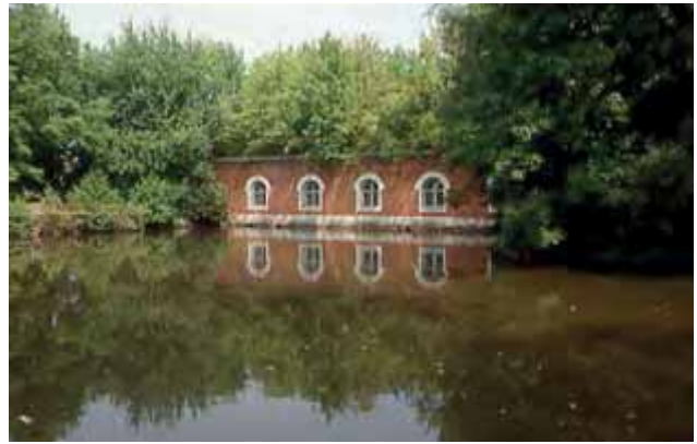
Abbildung 8: Der Künettegraben (Foto: Gartenamt Ingolstadt, 1991)
