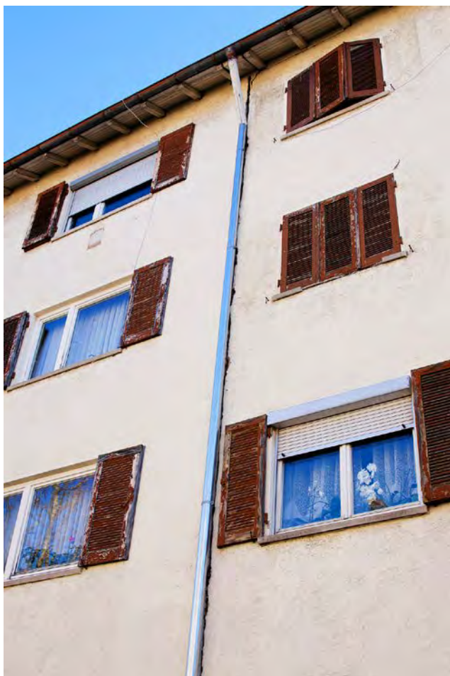
Abb. 3: Teilweise sind es unauffällige Strukturen, die relevant für Arten sind: In dem Spalt hinter dem von der Dachrinne kommenden Fallrohr nistet eine Haussperlings-Kolonie ( Passer domesticus , Foto: Johannes Mayer).
