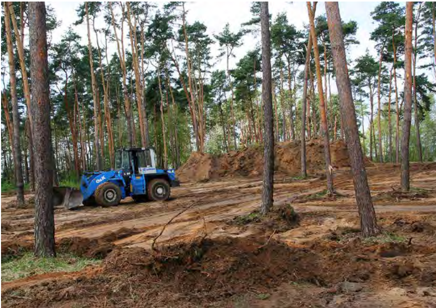
Abb. 3: Zirka 30 cm des Oberbodens werden abgeschoben und abgefahren.
