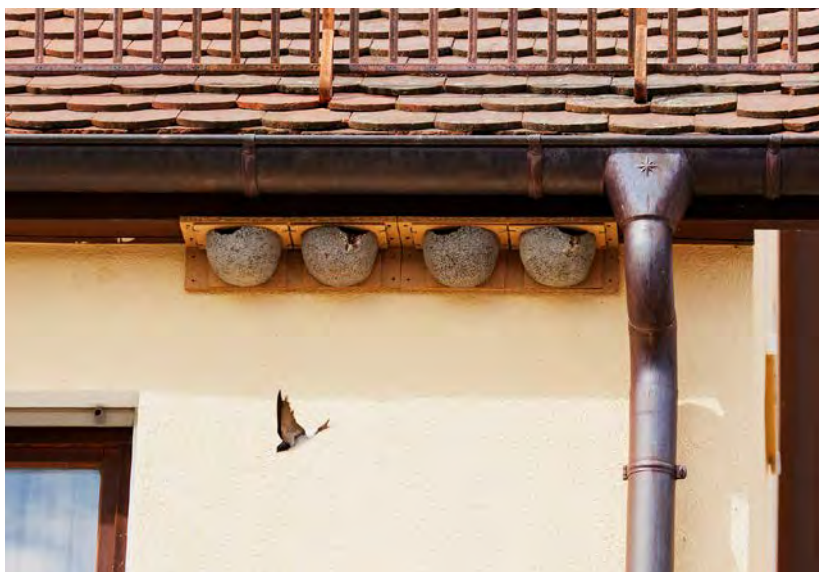
Abb. 2: Eine von zahlreichen Lösungsmöglichkeiten im Gebäude-Artenschutz: Besetzte künstliche Nisthilfen für die Mehlschwalbe ( Delichon urbicum ) unter einem Dachvorsprung (Foto: Jennifer Theobald).
