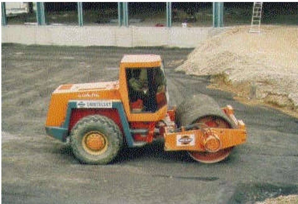
Abb. 11: Verdichtung der eingebauten Müllverbrennungsschlacke mittels Vibrationswalze am Tag der Probenahme
