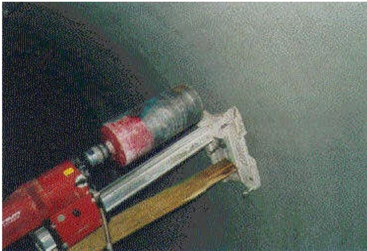
Abb. 8: Kernbohrung in einem Versorgungsschacht unter dem Schlackekörper
