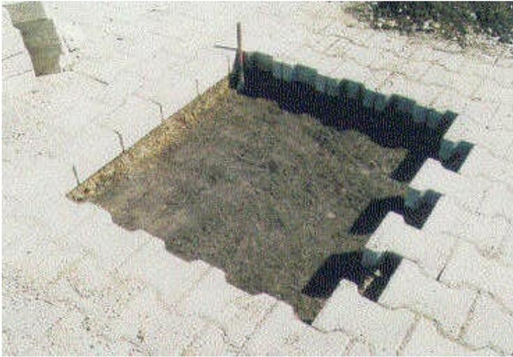
Abb. 9: Beprobung einer Schlackegründung durch Abtragung der Betonstein-/Splitt-Überdeckung
