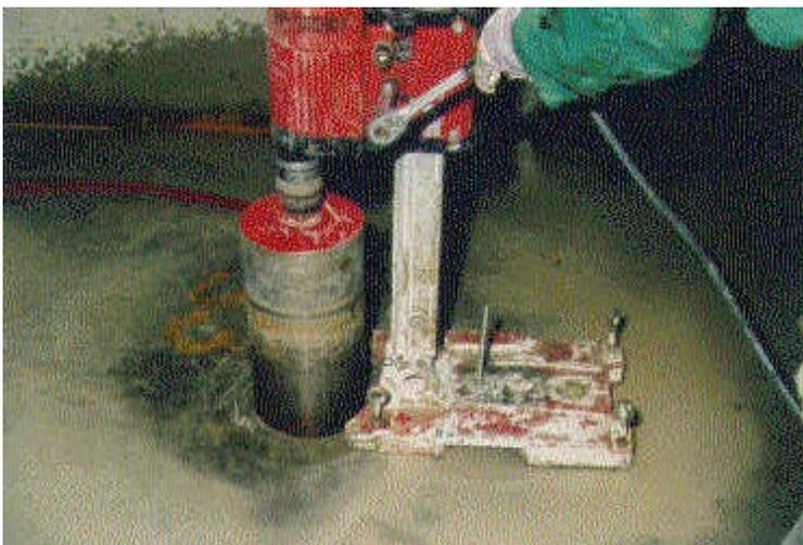
Abb. 7: Kernbohrung durch den Hallenboden (Betonplatte)
