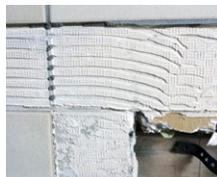
Erst in den letzten Jahren wurde das Ausmaß von Asbestbeimischungen in bauchemischen Produkten wie Farben, Putzen, Spachtelmasse, Fliesenkleber und weitere Materialien deutlich. Sanierungen gestalten sich hier aufwendig.
