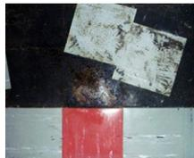
Asbesthaltige Bodenbeläge gibt es beispielsweise in Form von PVC-Fliesen. Auch die Kleber und Ausgleichspachtelmasse unter Bodenbelägen und Fliesen können bei entsprechendem Baujahr asbesthaltig sein.
