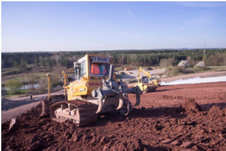
Abb. 7: Einbau mineralische Tonabdichtung
