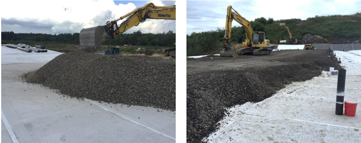
Abb. 3 und 4: Vor-Kopf-Einbau der Entwässerungsschicht im Baufeld
