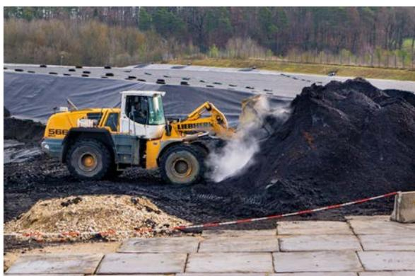
Abb. 3: Einbau von Abfällen in der DK III-Deponie Raindorf
