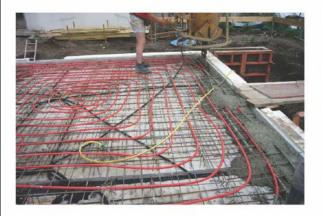
Betonkernaktivierung zur Kühlung im Sommer und Heizung im Winter Nutzung von Grundwasserkälte möglich
