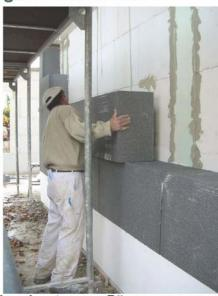
Wärmedämmverbundsystem zur Dämmung von Außenwänden (hier Passivhaus-Standard)
