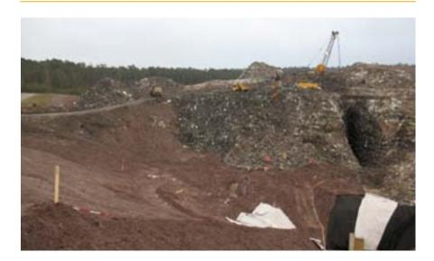
Deponie Gosberg: Neue DK-Il-Baugrube; im Vordergrund Schrägschachtbauwerk zur Sickerwassererfassung; im Hintergrund die Altdeponie mit Baugrube der Sanierungsmaßnahme des Sickerwassersystems.
