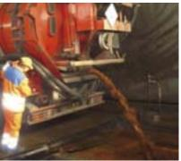
Absaugen von Rückspülschlamm aus einem Absetzbecken und Entleerung des Saugwagens bei einer Entsorgungsfirma
