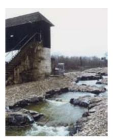
Wiederherstellen der Durchgängigkeit am Ickinger Wehr (Isar) durch eine Fischaufstiegsanlage (hier: Beckenpass)
