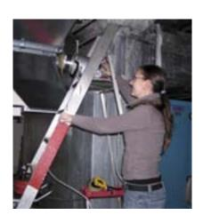
lodfilterkontrolle: Mit Hilfe eines Hochleistungsluftsammlers werden Proben aus dem Sammelkanal entnommen.
