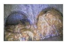
Starke Verockerungen an der Schachteinmündung der Sickerwasserleitungen am Surspeicher (Aufnahme aus einer Kanalbefahrung)
