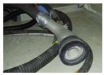
Rückbau des Kernkraftwerkes Gundremmigen Block A: mittels "VacuBlast"-Strahlverfahren dekontaminierter Raum (Bild oben) und der "VacuBlast"-Strahlkopf (Bild unten)
