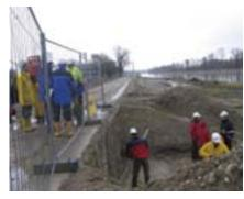
Sanierung der Mangfalldeiche mit unbewehrten Erdbetonwänden (links) und Kontrolle der freigelegten Erdbetonwand (rechts)
