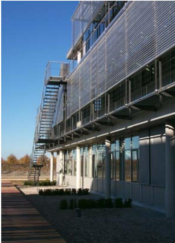
Abb. 6: Verstellbarer außen liegender Sonnenschutz zur Vermeidung äußerer Lasten
