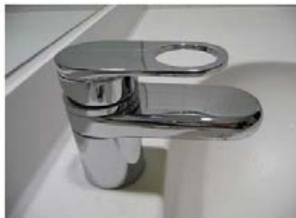
Einhebelmischer in Mittelstellung
