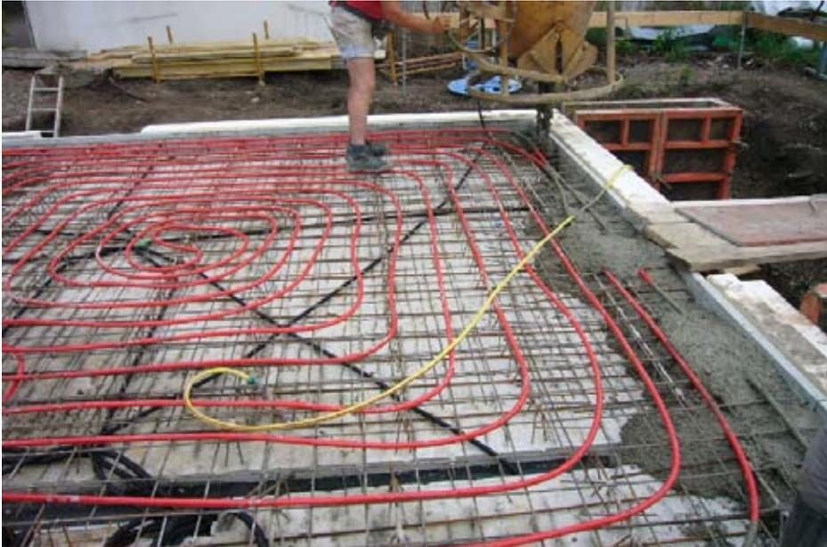
Abb. 9: Nutzung von Grundwasserkälte zur Gebäudekühlung mittels Betonkernaktivierung
