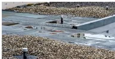
Abb. 5: Schwerpunkt Baustoffe: mit Dachpappe verkleidetes Flachdach mit Regenlachen
