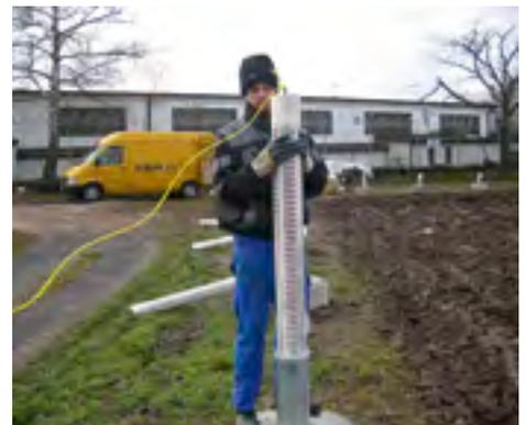
Dazu wurden bereits zwei Brunnengalerien mit je 30 Injektionsbrunnen errichtet. Über diese Brunnen werden Filtersocken mit ca. 3.000 Kilogramm Reaktionsmaterial eingebracht. Dieses Material setzt langsam über mehrere Monate Sauerstoff frei, um einen nachhaltigen biologischen Abbau der Schadstoffe durch Bakterien zu bewirken. Gerechnet wird mit einer Sanierungsdauer von vier bis fünf Jahren. Eine Sanierung per konventionellem Abpumpen würde hingegen deutlich mehr als 20 Jahre in Anspruch nehmen.
