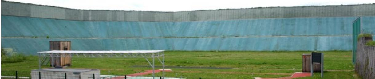
Abb. 9: Erdwall (belegt mit Netzen und aufgesetztem Gabionensystem) bei kombinierter Trap-/Skeetanlage Olympia-Schießanlage Garching (Bayern)
