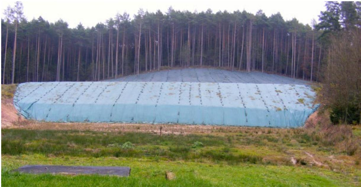
Abb. 8: Flächiger Schrotfang mit Netzen, WSSA Weismain, Bayern
