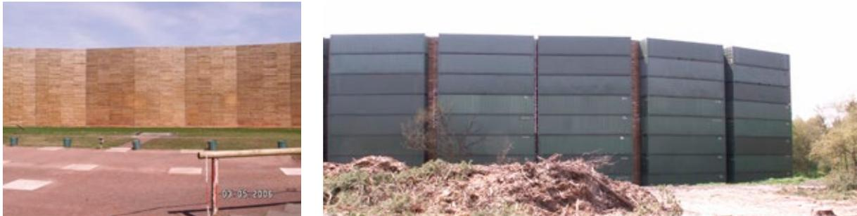
Abb. 11: Schrotfang aus gestapelten Seecontainern mit Holzverkleidung, WSSA Liebenau (Niedersachsen)
