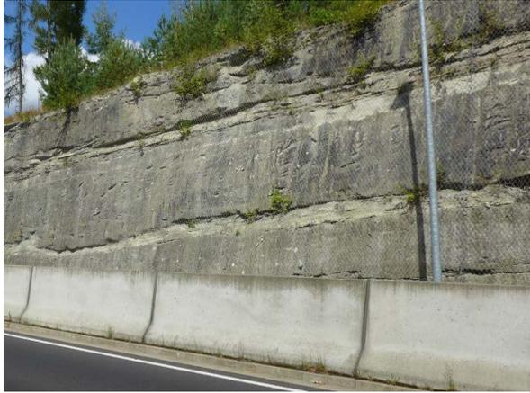
Abb. 1: Beräumter und mit Netzen gesicherter Felsbereich aus Sandstein an der Straße zwischen Netzberg und Grafenwöhr.
