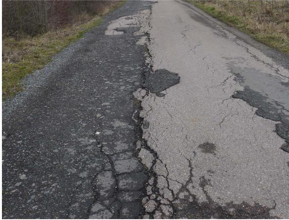
Abb. 4: Das Foto zeigt eine stark beschädigte Straße, bedingt durch die Rückverlagerung der Anbruchkante einer Rutschung südlich von Lindenhof.
