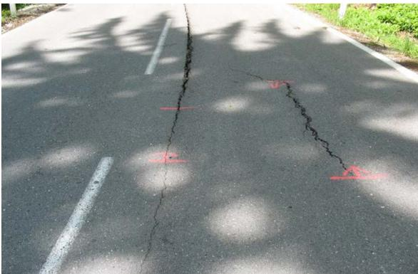
Abb. 5: Durch eine Rutschung verursachte Straßenschäden an der St 2071 südöstlich Kloster Schäftlarn
