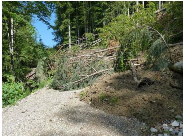
Abb. 4: Rutschung nach einem Starkregenereignis nordöstlich der Bichlerhütte im Steinbachtal
