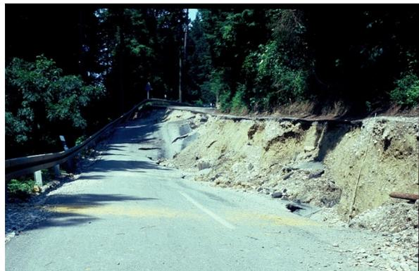
Abb. 6: Durch eine Rutschung verursachte Straßenschäden an der St 2071 südöstlich Kloster Schäftlarn
