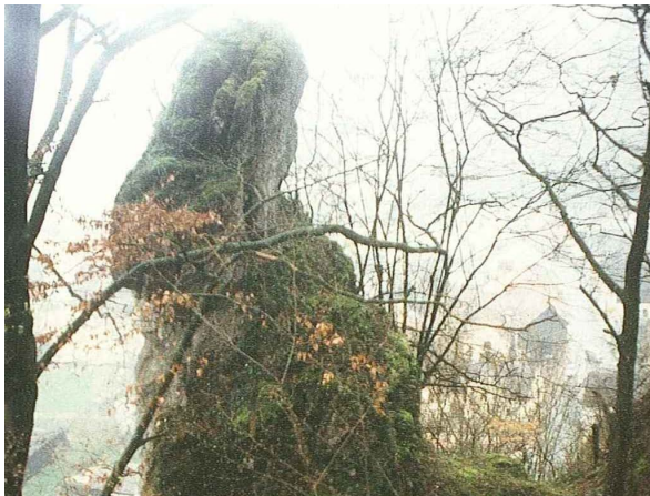
Abb. 2.: 1997 ereignete sich an einem Felsvorsprung am Schlossberg Harburg ein Steinschlag.
