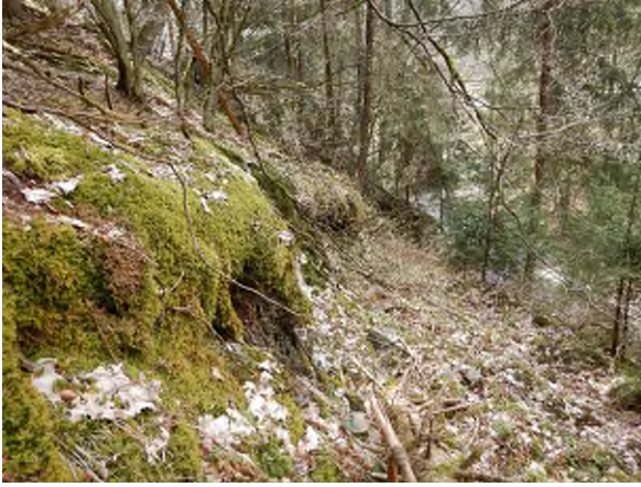
Abb. 11: Deutlich ausgebildete Anbruchkante entlang steil einfallender Trennflächen im Landkreis Kronach.
