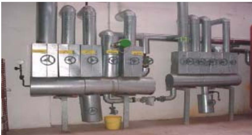
Abb. 19: Vorbildliche Wärmedämmung an Leitungen und Armaturen des Warmwassernetzes
