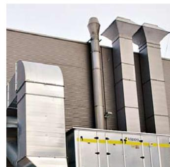
*Um bis zu 50 Prozent lässt sich die abzusaugende Luftmenge durch eine (Teil-) Abdeckung der Prozessbäder verringern.*
