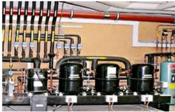
*Kälteverbundanlage: Eine Kälteverbundanlage ermöglicht Teillastbetrieb und eine Nutzung der Abwärme.*
