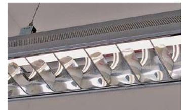
Mit modernen Spiegelrasterleuchten lassen sich in vielen Fällen zwei Leuchtstofflampen durch eine ersetzen.
