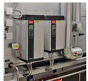
Frequenzumrichter regeln die Leistungsaufnahme.
