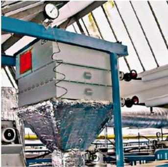
Luft/Luft-Wärmetauscher zur Vorwärmung der Frischluft mit Wärme aus der Abluft
