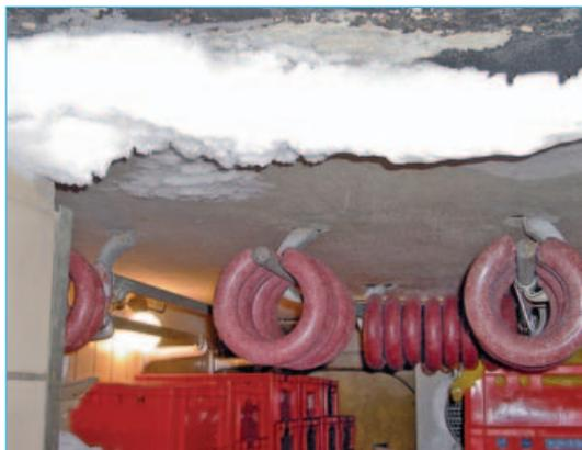
Vereisung aufgrund undichter Kühlraumtür
