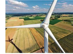
Auch bei Windenergieanlagen entsteht Infraschall: Zum einen streichen die Rotorblätter am Turm vorbei und erzeugen dabei Infraschall. Eine zweite Ursache sind Vibrationen in den Flügeln und im Turm. Zusätzlich entstehen auch Geräusche im gesamten Frequenzbereich, vor allem durch Turbulenzen an den Rotorblättern. Wie viel Infraschall entsteht, hängt im Wesentlichen von zwei Aspekten ab:
