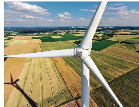
Auch bei **Windenergieanlagen** entsteht Infraschall: Zum einen streichen die Rotorblätter am Turm vorbei und erzeugen dabei Infraschall. Eine zweite Ursache sind Vibrationen in den Flügeln und im Turm. Zusätzlich entstehen auch Geräusche im gesamten Frequenzbereich, vor allem durch Turbulenzen an den Rotorblättern. Wie viel Infraschall entsteht, hängt im Wesentlichen von zwei Aspekten ab:
