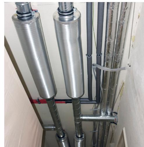
Wickelfalzrohr mit integrierten Schalldämpfern
