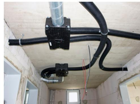
Sternförmige Erschließung über schallgedämmte Verteilboxen
