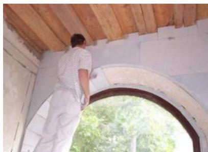
Abb. 2: Einbau Innendämmung
