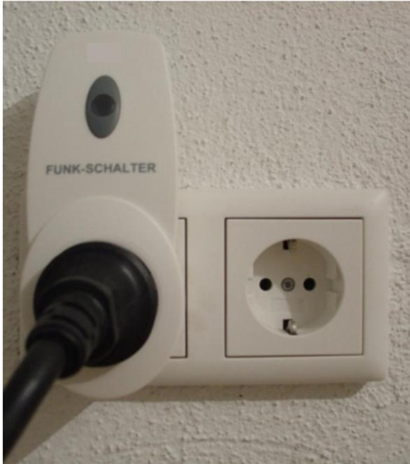
Abb. 17: Funkschalter/Funksteckdose mit eingestecktem Kabel einer Zirkulationspumpe im Technikraum
