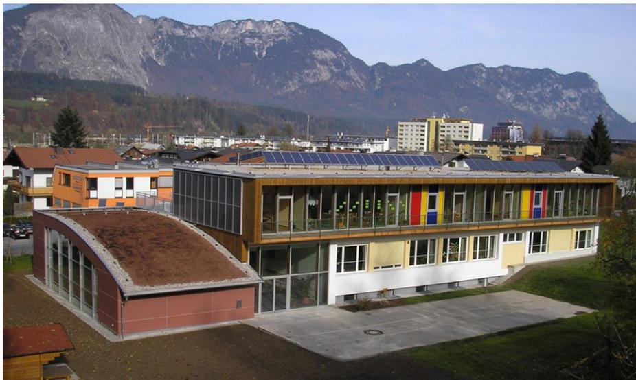
Abb. 35: Außenansicht der Kita Wörgl im Inntal. Links befindet sich der neue Anbau der Mehrzweckhalle. Ebenso wurde durch ein neues Obergeschoss der Altbestand aufgestockt. Die Gruppenräume sowie der Mehrzwecksaal sind mit einer Lüftungsanlage ausgestattet.
