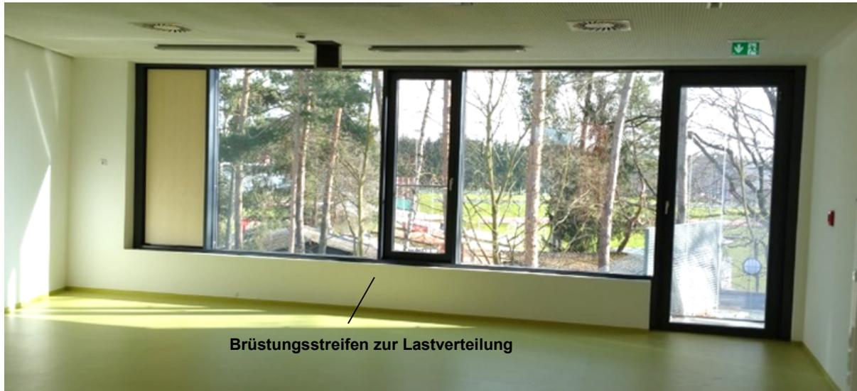
Abb. 10: Innenansicht eines Klassenzimmers der Viatisschule in Nürnberg. Statt einer bodentiefen Verglasung wurde ein Brüstungsstreifen geplant, um die Last gleichmäßig abzutragen.
