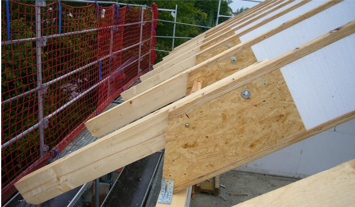
Abb. 16: Ein schlanker Dachüberstand kann durch separate Sparrenköpfe realisiert werden.
