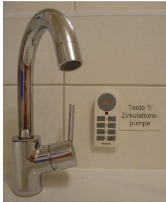
Abb. 18: Mit einer Fernbedienung wird der Funkschalter im Technikraum aktiviert.
