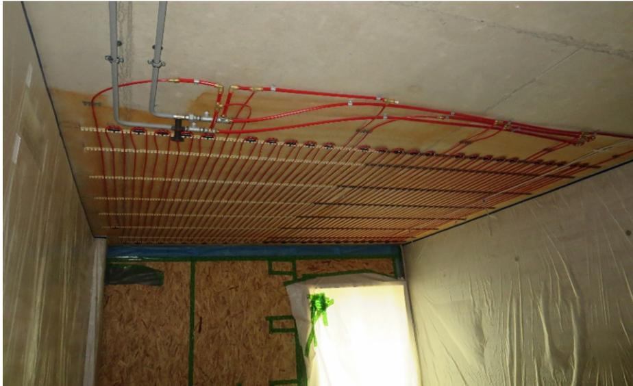
Abb. 30: Belegung von Teilflächen der Bürodecken für die Heizung und Kühlung des Landesamts für Gesundheit und Lebensmittelsicherheit in Erlangen
