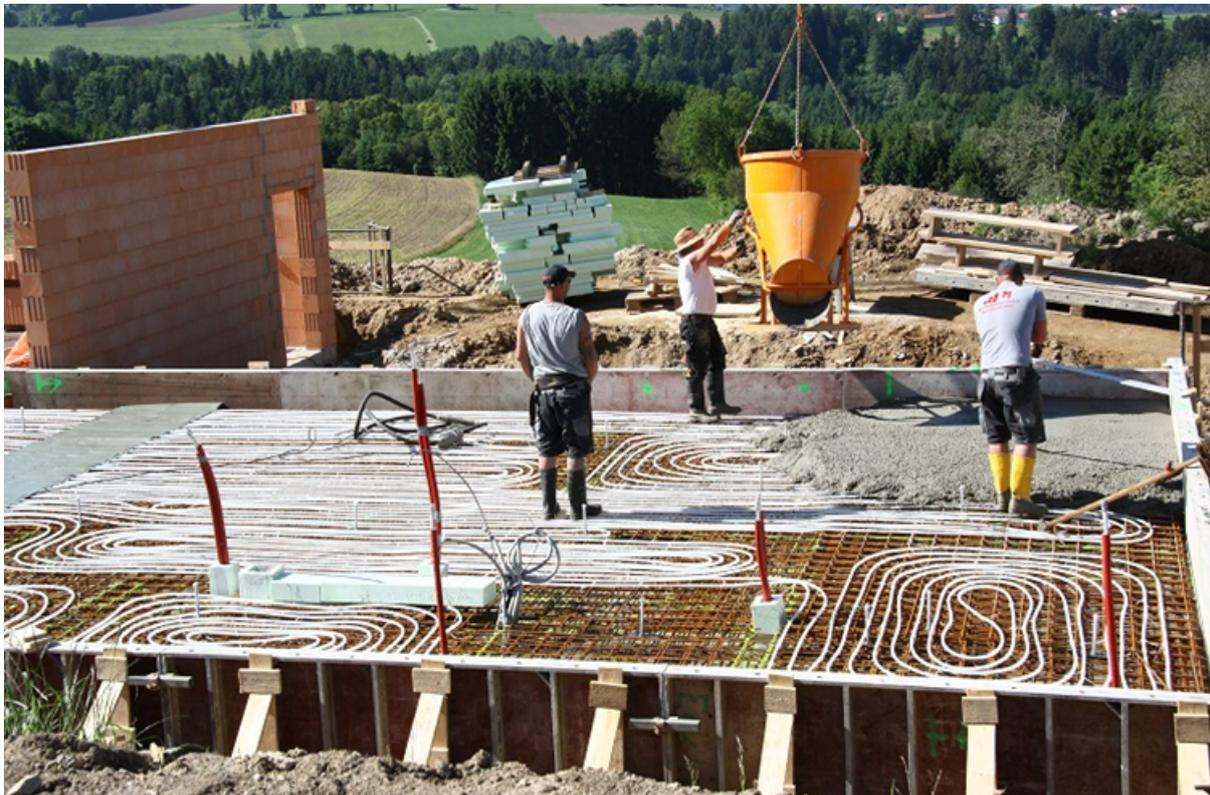
Abb. 11: Die Rohre für die spätere Fußbodenheizung können direkt auf der Oberbewehrung des Betonstahls aufgebracht werden, um die Betonplatte zu aktivieren.
