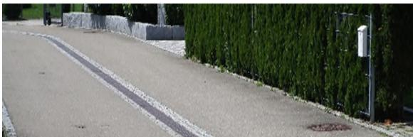
Abb. 17: Linienentwässerung
