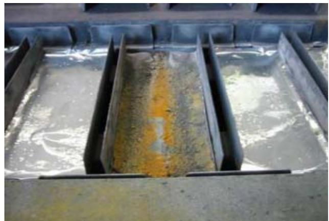
Der Feinstaub am Boden der Absaugkanäle muss in größeren Zeitabständen, wie bei herkömmlichen Absaugkanälen auch, entsprechend den Forderungen der BGV D 25 entfernt werden und kann bei vollständiger Aushärtung u. U. über den Hausmüll entsorgt werden.
