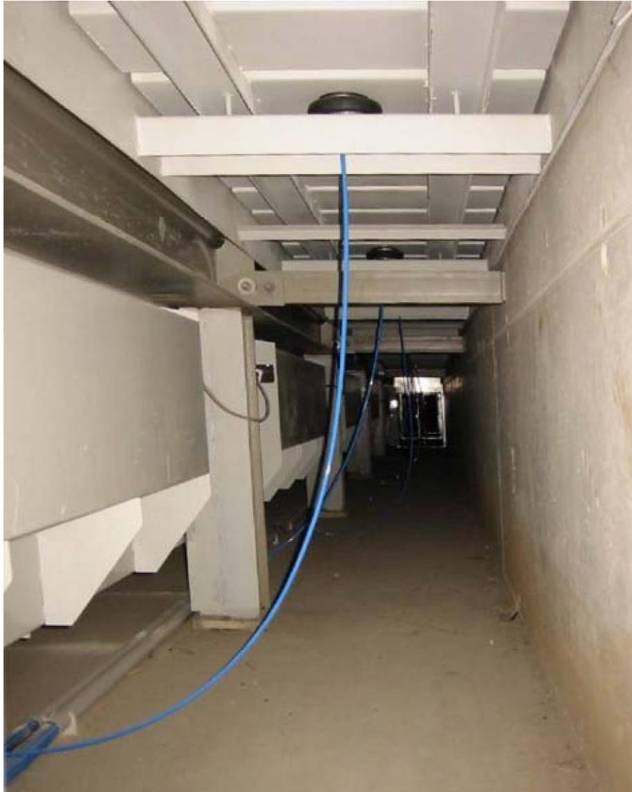
**Sektional schaltbarer Absaugkanal**
