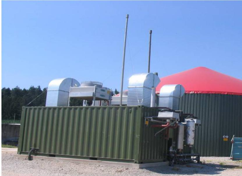
Abb. 5: Foto des BHKW 4 (110 kW<sub>el.</sub> Zündstrahl-Motor) im Container vor dem Fermenter mit Gaspeicher
