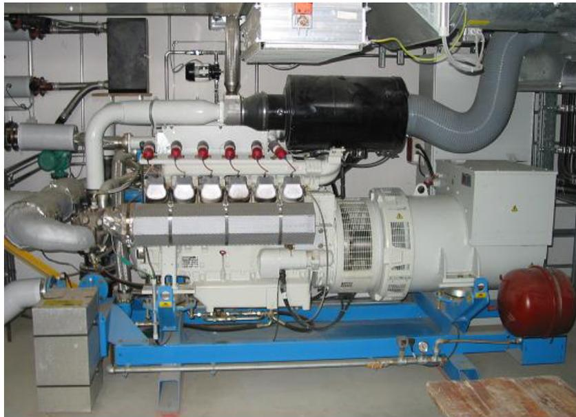
Abb. 3: Foto des BHKW 2 (324 kW<sub>el.</sub> Gas-BHKW)
