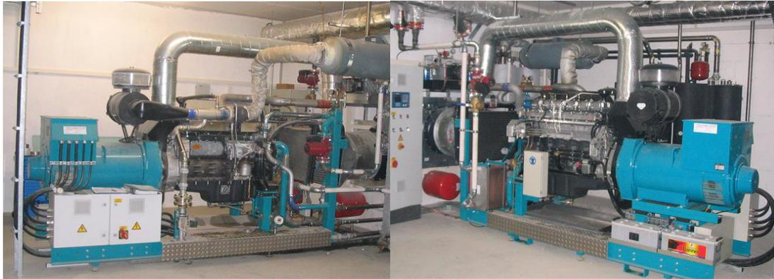
Abb. 6: Fotos der BHKW 5 und 6 (250 kW<sub>el.</sub> und 265 kW<sub>el.</sub> Zündstrahl-Motoren)
