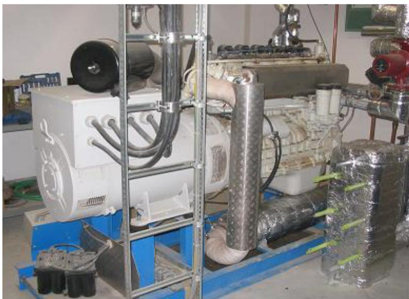
Abb. 2: Foto BHKW 1 (Gas-Otto-Motor, 190 kW<sub>el.</sub>)
