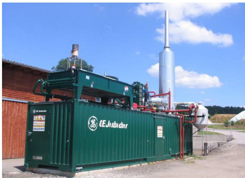
Abb. 4: Foto des BHKW 3 (526 kW<sub>el.</sub> Gas-Otto-Motor) im Container
