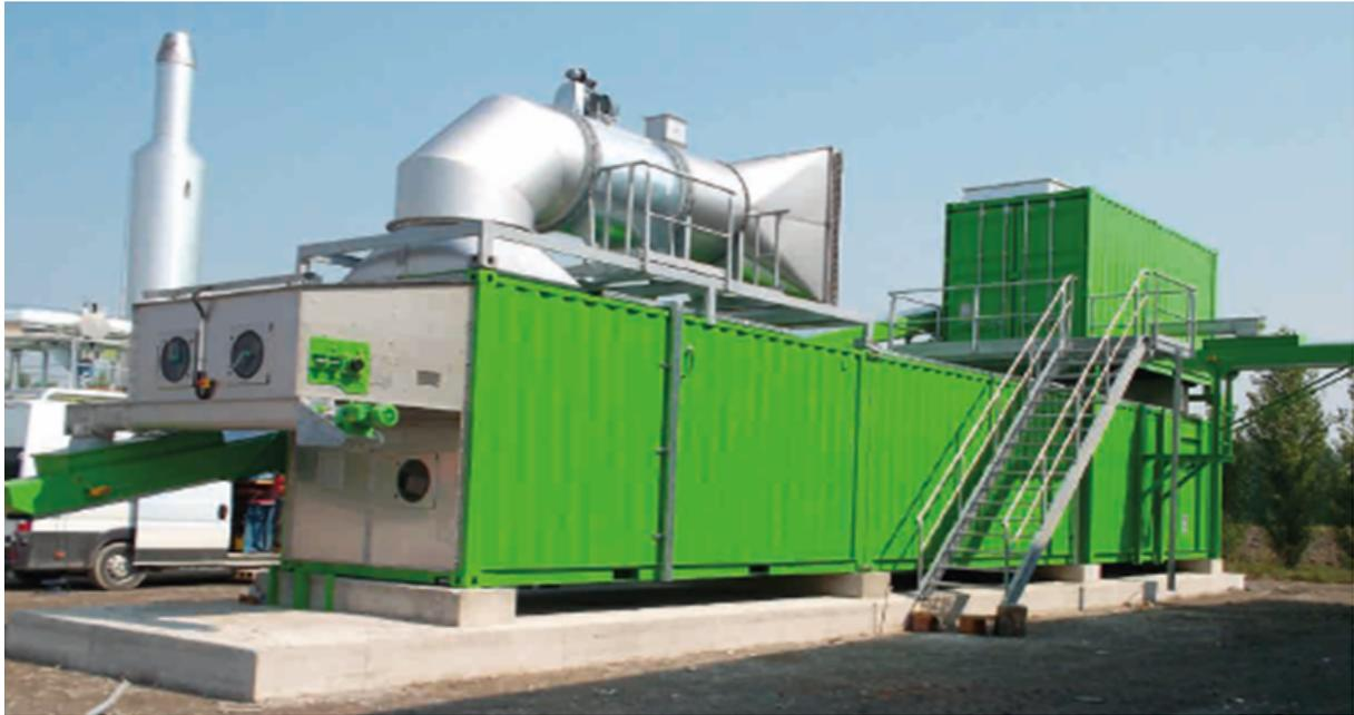
Abb. 31: Kombiniertes Trocknungsverfahren (direkt mit BHKW-Abgas und indirekt über Wärmetauscher) vergleichbar der Anlage B nach *NEW eco-tec Verfahrenstechnik GmbH*
