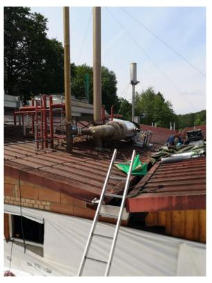
Abb. 39: Messstelle BHKW-Abgas Anlage C nach Betreiber Anlage C (2021)
