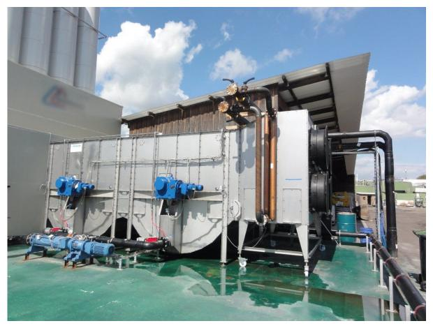
Abb. 14: Beispielanlage eines Schaufelradtrockners mit zwei Wannen nach Einkammerer
