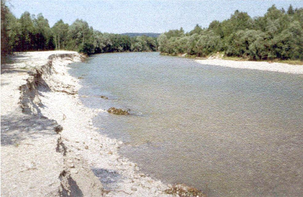
Abb. 7: Die Isar bei Icking nach dem Uferrückbau im Jahre 1999 (Foto W.Binder)
