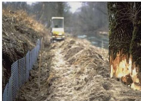
Ein Drahtgitter im Erdreich verhindert, dass der Biber seine Erdhöhlen oder Kanäle in die Uferböschung gräbt. (Foto Günter von Lossow)
