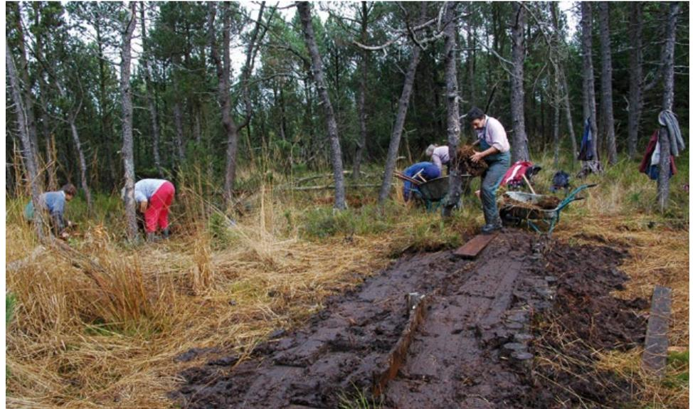
Schließen eines Moor-Entwässerungsgrabens durch den Bund Naturschutz Weilheim: Zwischen eingeschlagenen Holzpallisaden wird eine verdichtete Torfpackung zuletzt mit abgestochenen Grassoden überdeckt. So wird ein optimaler, dauerhafter Wasserstau gewährleistet (Foto: Andreas Zehm).
