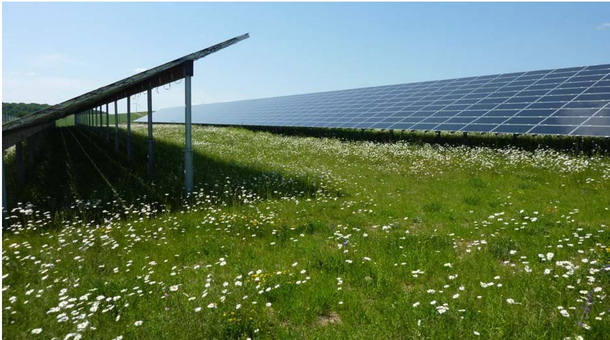
Abb. 61: Photovoltaik Eckartshausen: großzügige Durchblicke durch hohe Module mit größeren Abständen zwischen den Modultischen
