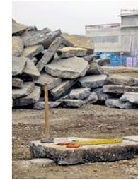
Abbruchplatten aus Beton werden zu neuen Trockenmauern aufgebaut.
