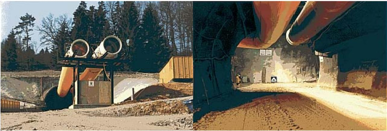
Abb. 11: Frischluftzufuhr bei der Spritzbeton-Bauweise [15]
