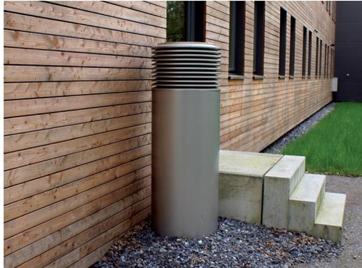
*Ansaugöffnung für kontrollierte Wohnraumlüftung (mindestens 1,5 m über Boden)*
