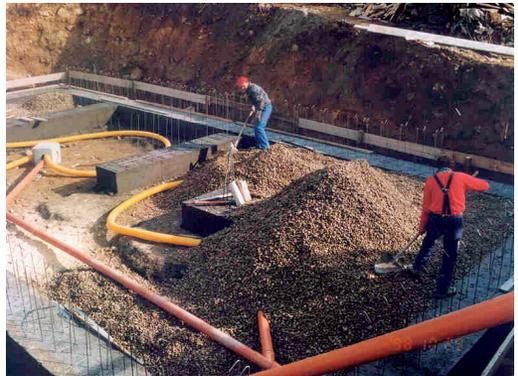
*Einbau einer Radondrainage in Kies beziehungsweise Schotter*
