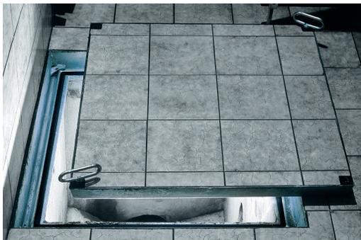
*Alle Öffnungen in Fundamentplatten – wie etwa Kanal-Putzschächte – müssen immer gasundurchlässig abgedichtet werden.
