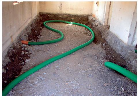
*Erneuerung des Fußbodenaufbaues: Einbau einer Radondrainage.*
