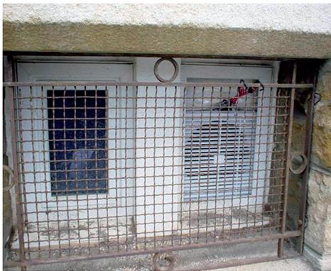
Mit einem kleinen Ventilator wird im Kellergeschoss oder Kriechkeller ein Unterdruck gegenüber dem Wohnbereich erzeugt.
