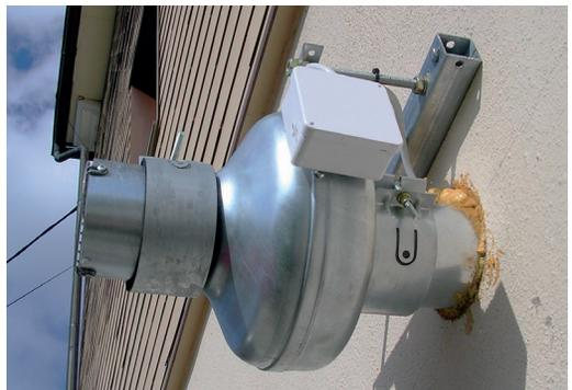
*Ein außen liegender Ventilator erzeugt einen leichten Unterdruck unter der Bodenplatte.*
