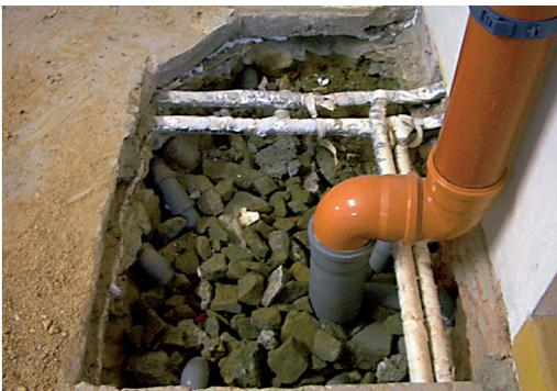
*Punktueller Absaugung (Radonbrunnen) – Aushub eines Schachtes.*
