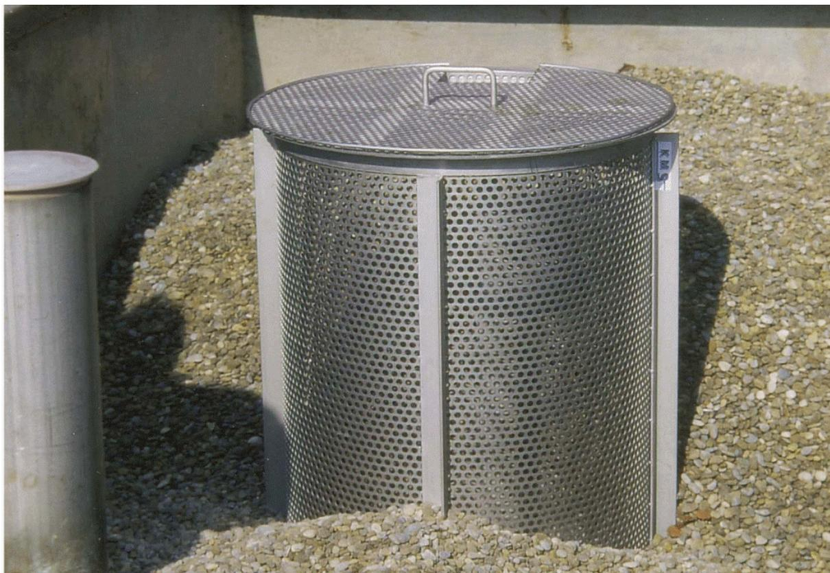
Abb. 28: Geotextilfiltersack in einem Sickerschacht aus Edelstahl-Lochblech (Feld AGEO)
