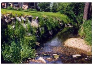
Abb. 4 und 5: Vorher und Nachher: Mitarbeiter des GUZV konnten die stark unterspülte Mauer am Moosgraben naturnah und kostengünstig mittels Wasserbausteinen ersetzen und dadurch das Ufer dauerhaft sichern.
