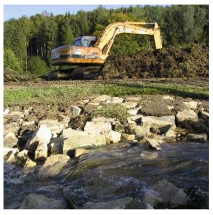
Abb. 2 und 3: Renaturierung der Schwarzach durch Ausbau der starren Sohlbefestigung und Wiedereinbau als naturnahe Sohlschwelle.
